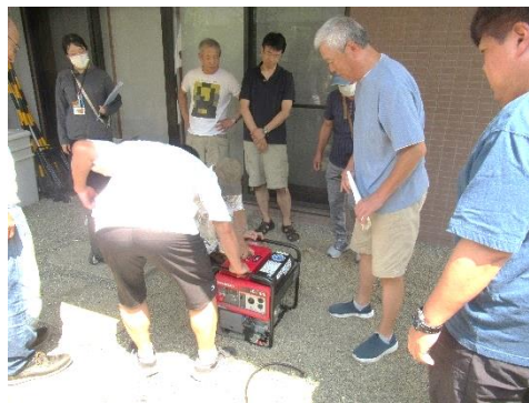
発電機の試運転
